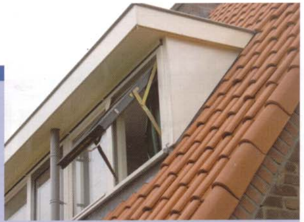
Op de verdieping zijn de ramen vervangen door zogenaamde uitzetkramen die naar buiten tuimelen en het zo mogelijk maken zelf ramen te lappen.
