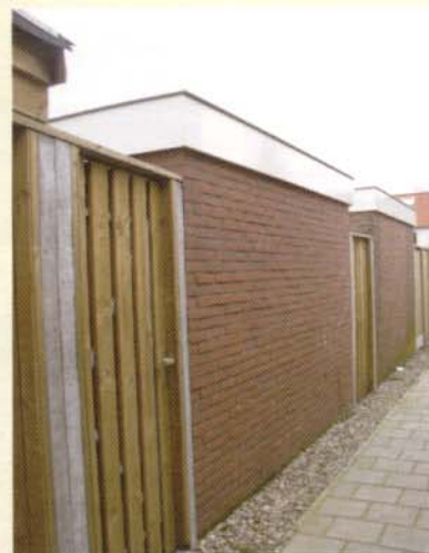
Bergingen werden waar nodig gesloopt en opnieuw opgebouwd.
