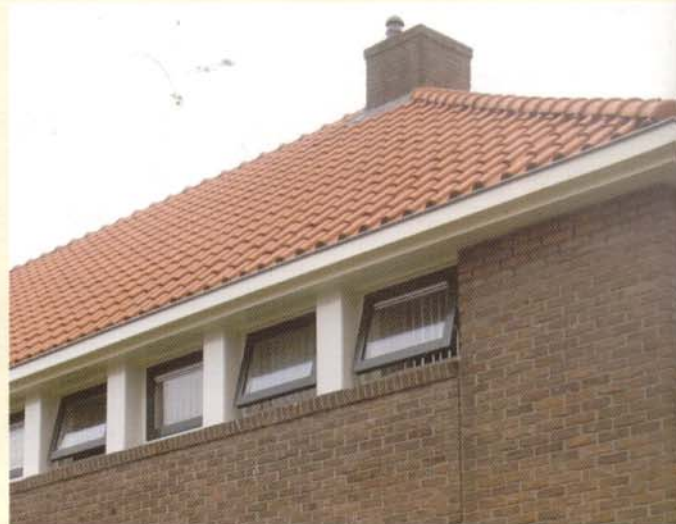
Bij de vorige opknabbeurt zijn de karakteristieke rode dakpannen vervangen door betonnen sneldekkers. Een verandering die bij de laatste renovatieronde ongedaan is gemaakt.
