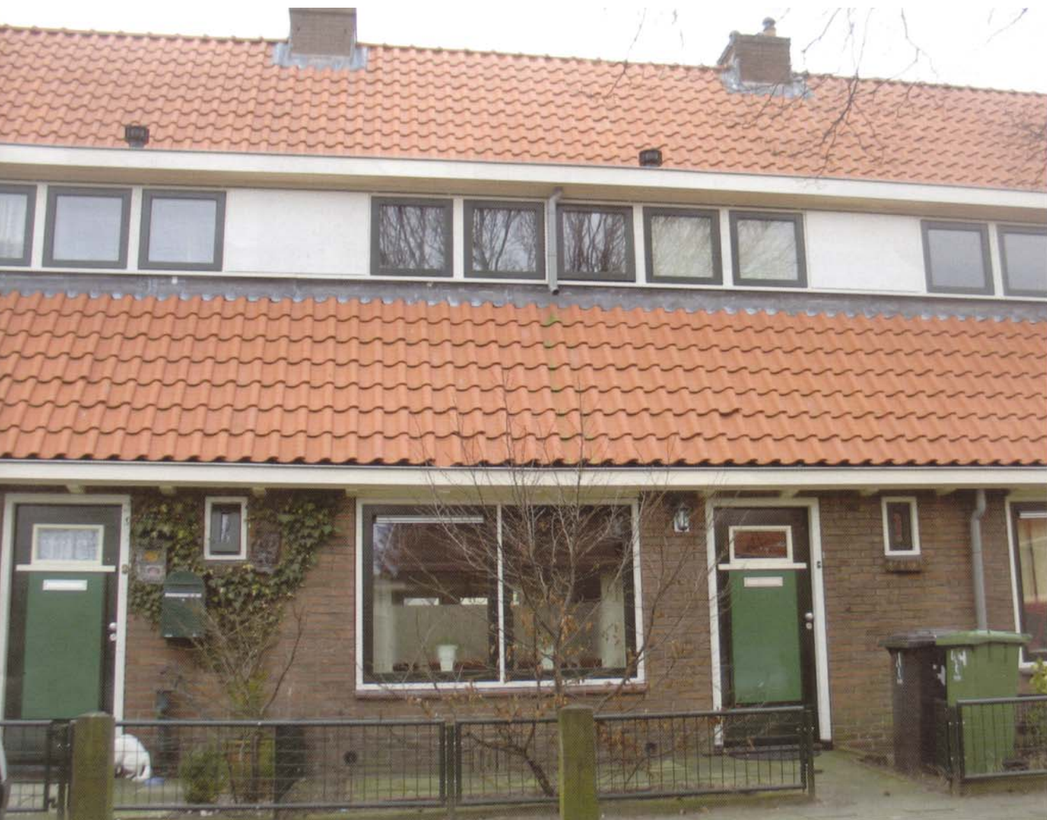
De 56 woningen aan de Galvanistraat en Edisonstraat waren het veertiende woningbouwcomplex dat Dudok in 1929 voor de gemeente Hilversum ontwierp.
