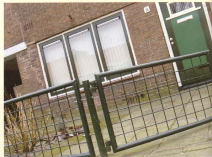
De raampartijen die eerder plaats moesten maken voor 'etalageruiten' zijn nu vervangen door ramen in de stijl van Dudok. De voordeuren zijn ingeruild voor replica's van de Dudok-deuren uit de twintigerjaren. De hekwerken voor de huizen werden opnieuw gepoedercoat in één kleur.
